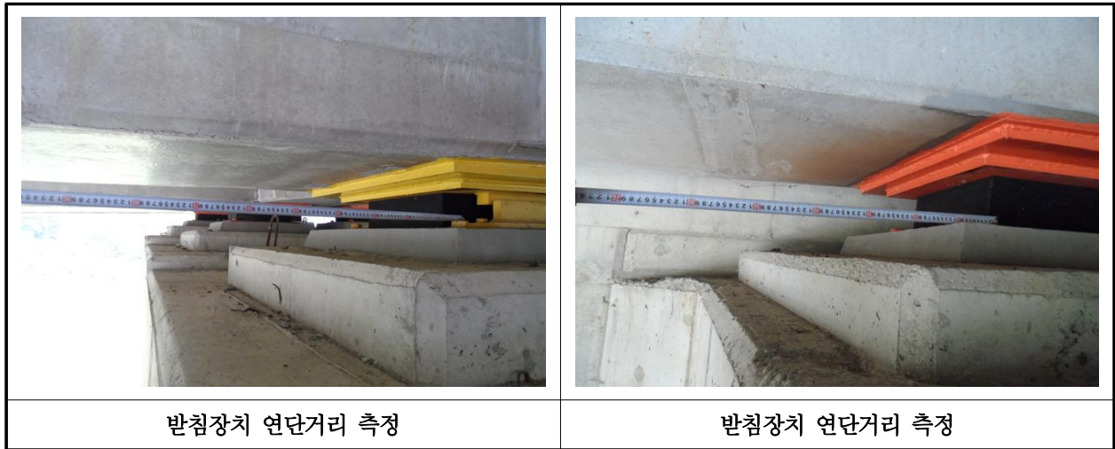
【사진 40.3.14】 교량받침장치 연단거리측정
