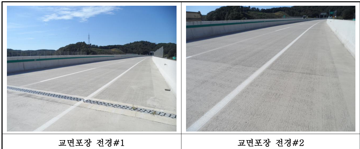
【사진 40.3.19】 교면포장 전경
