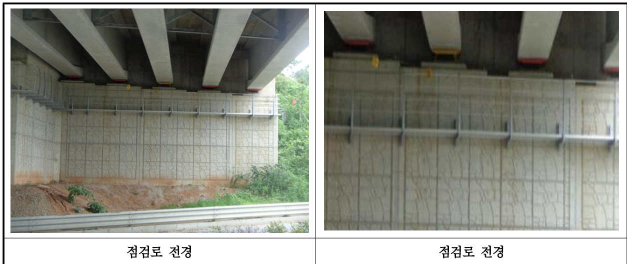
【사진 40.3.25】 교량 점검시설 전경
