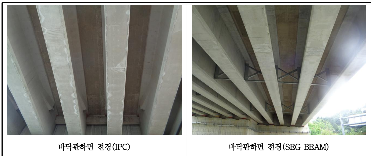
【사진 40.3.2】 바닥판하면 전경
