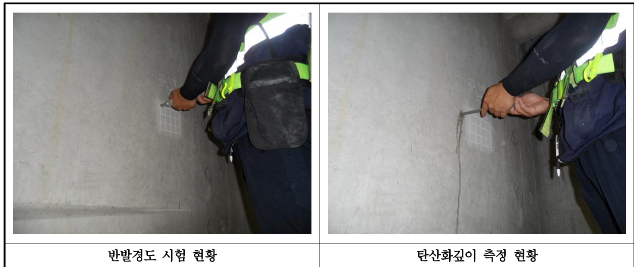
【사진 40.4.1】 콘크리트 내구성조사 현황
