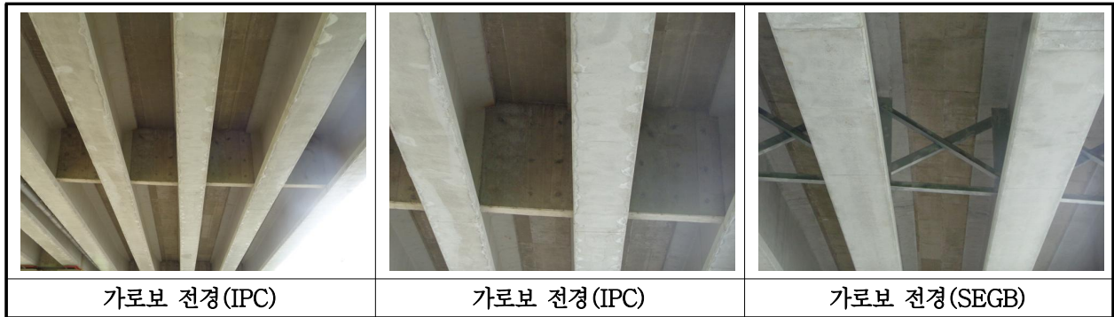
【사진 40.3.6】 가로보 전경
