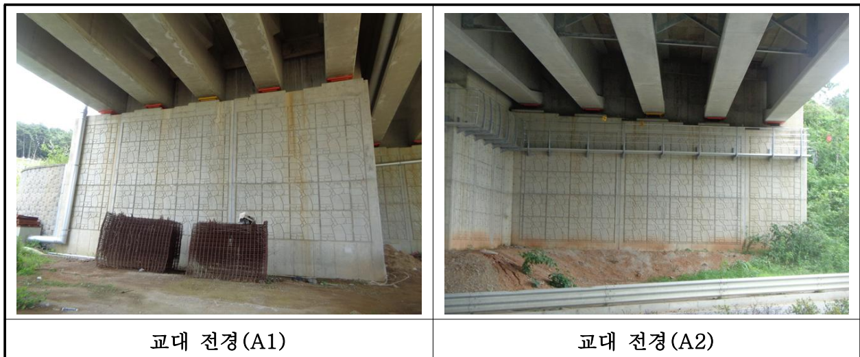
【사진 40.3.8】 교대 전경
