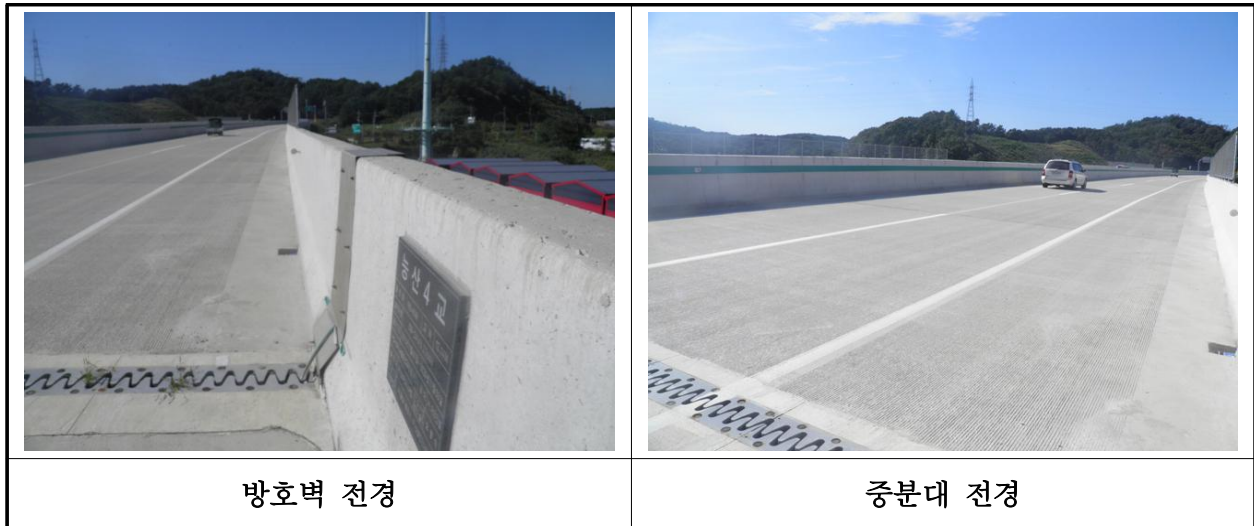
【사진 40.3.23】 방호벽 및 중앙분리대 전경
