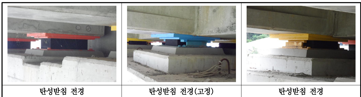
【사진 40.3.12】 교량받침 전경
